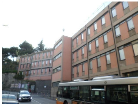
Figura 1.1 - Vista della facciata esposta a Est
