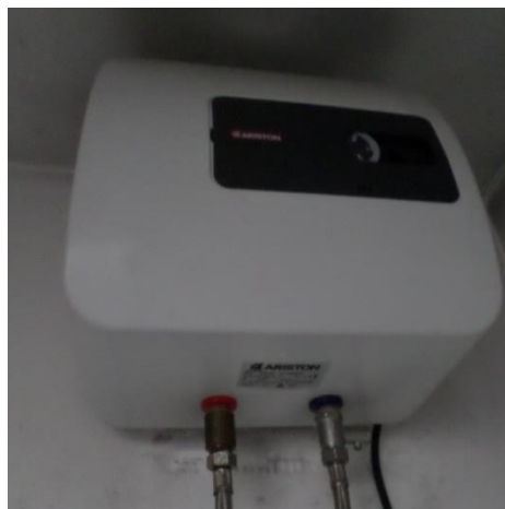
Figura 4.10 - Particolare di un boiler elettrico per la produzione di acqua calda sanitaria
